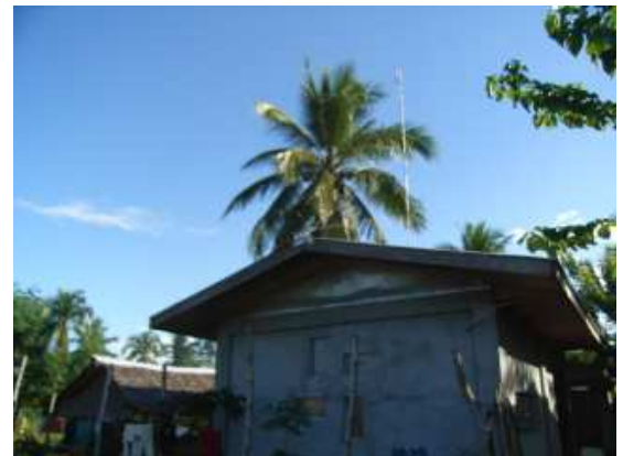
図書棟の屋根の上に立てられたアンテナ
