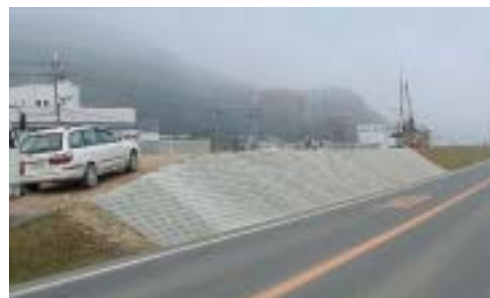
（一日市 県道から見る）
