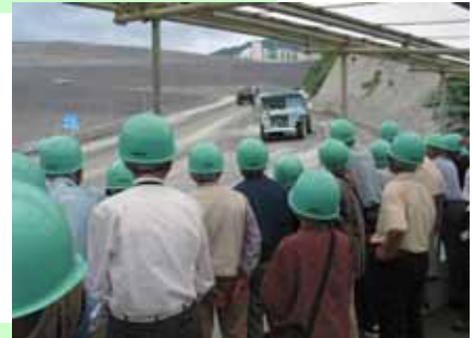
3 材料を運ぶ ダンプトラックを見る
